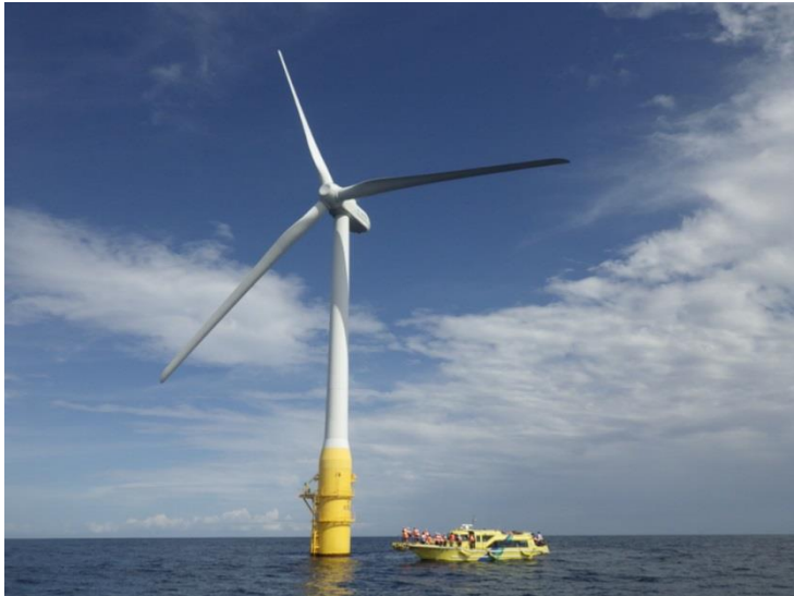
写真 五島沖 浮体式洋上風力（2MW、ロータ直径80m） ※1メッシュに設置できる風車規模のイメージ
