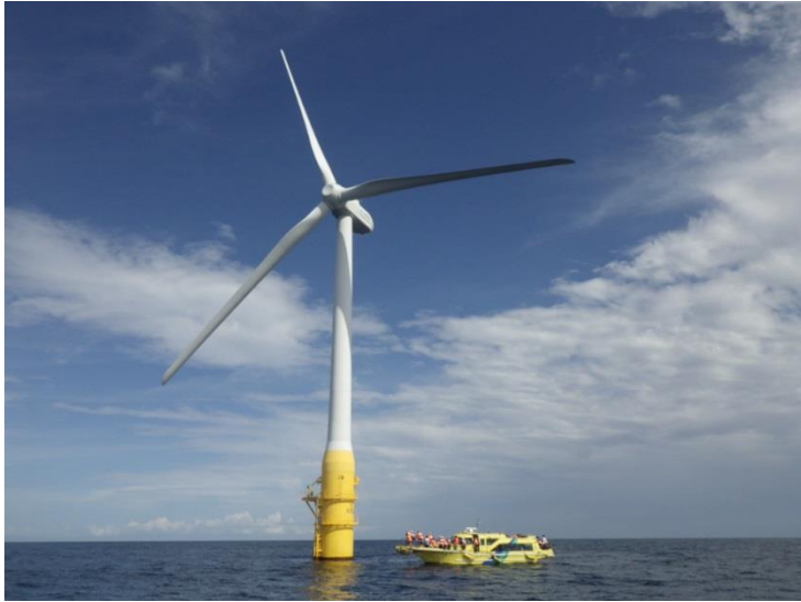
写真 五島沖 浮体式洋上風力（2MW、ロータ直径80m） ※1メッシュに設置できる風車規模のイメージ
