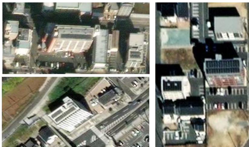
図 3.2-14 建物の傾きによる位置ズレ
