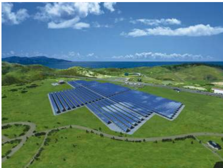
図 2-3 メガソーラー発電所（例 稚内市）
